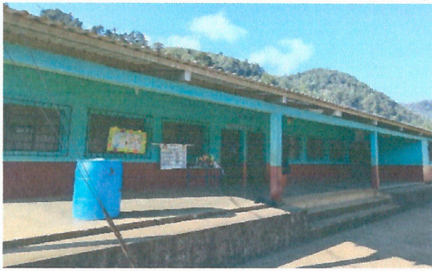
Foto 1: Mejoramiento de loza de patio
