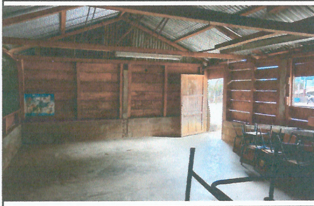
Foto 4: Mejoramiento de aula tipo pórtico
