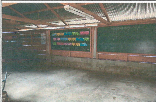
Foto 3: Mejoramiento de aula tipo pórtico
