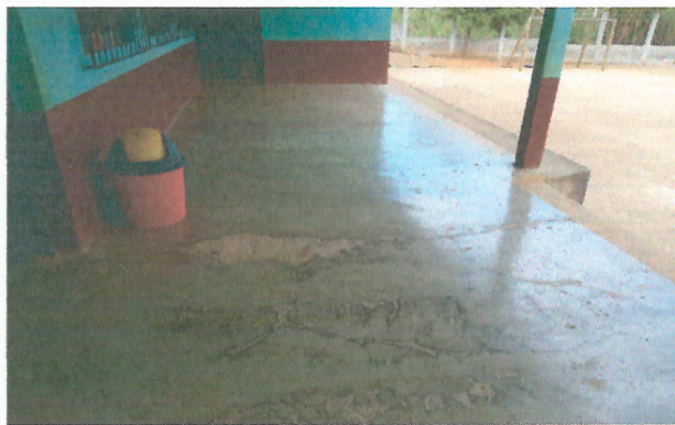
Foto 3: Mejoramiento de loza de patio
