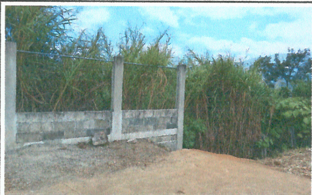
Foto 1: Mejoramiento de cerco perimetral
