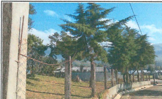
Foto 2: Mejoramiento de cerco perimetral
