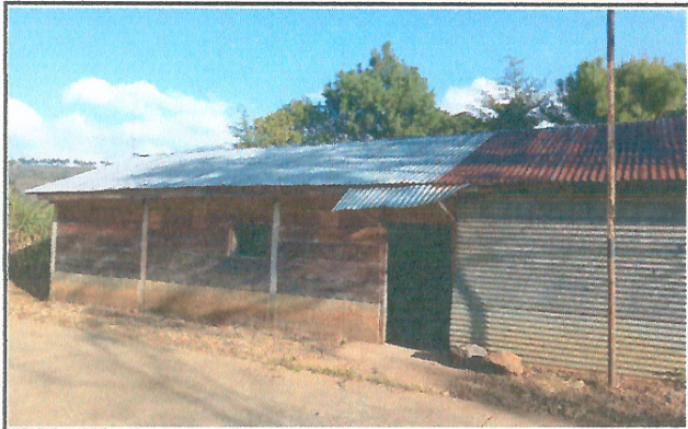
Foto 1: Mejoramiento de aula tipo pórtico
