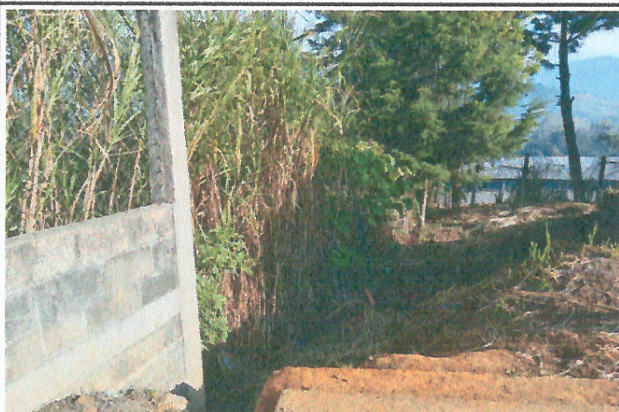
Foto 3: Mejoramiento de cerco perimetral
