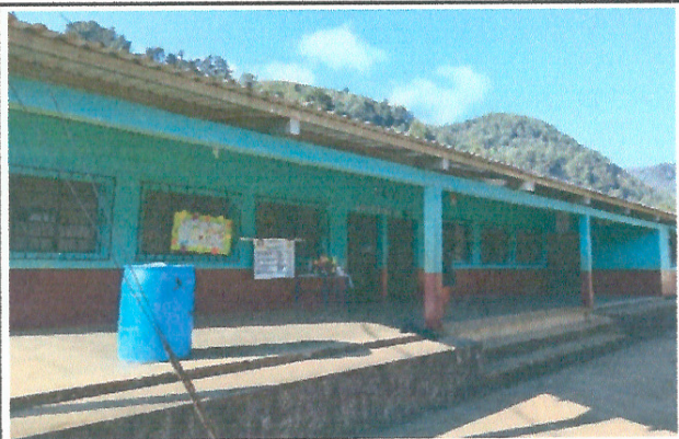
Foto 3: : Mejoramiento de aulas (piso cerámico de alto impacto)
