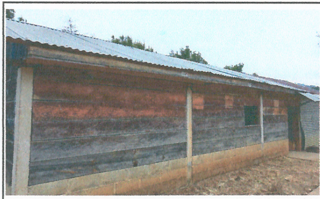
Foto 2: Mejoramiento de aula tipo pórtico
