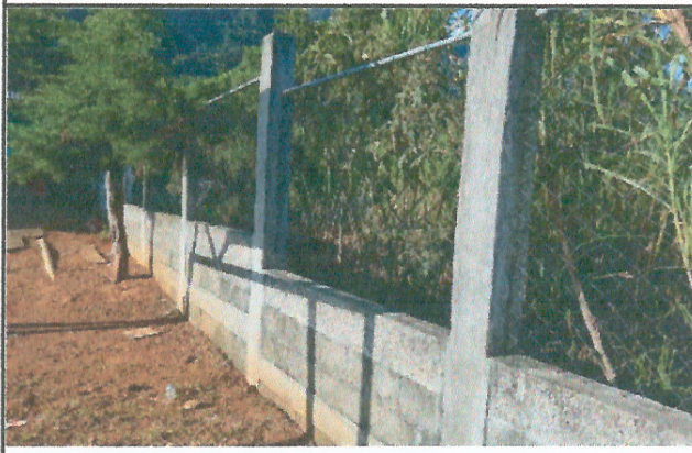
Foto 4: Mejoramiento de cerco perimetral
