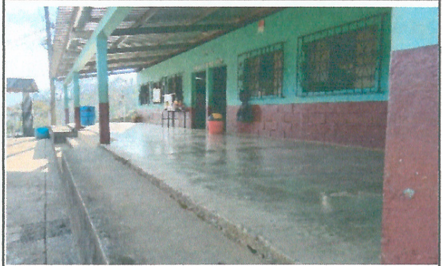
Foto 2: Mejoramiento de loza de patio
